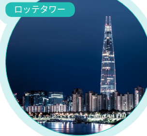
ロッテタワー
